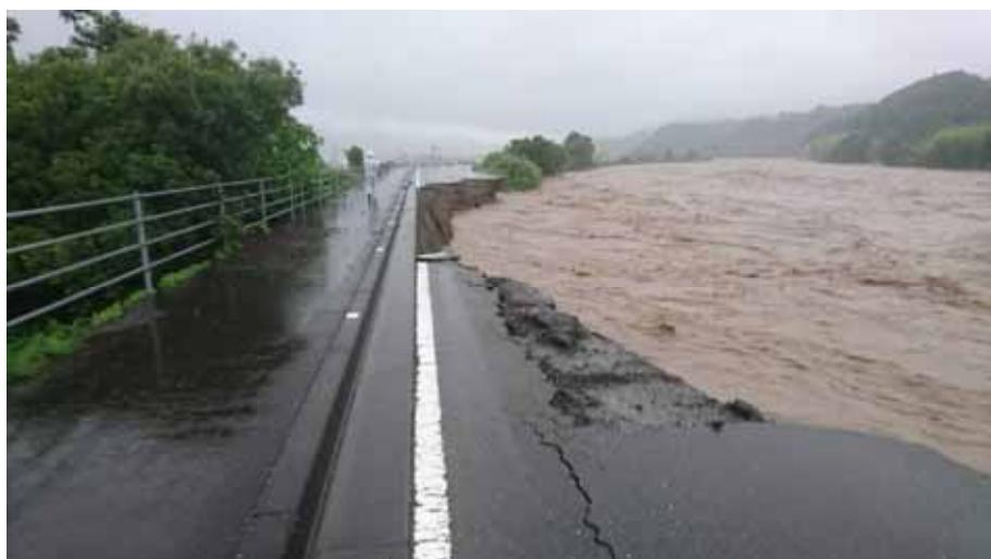
安芸川の増水で崩落した堤防と県道（平成 30 年 7 月安芸市僧津）
