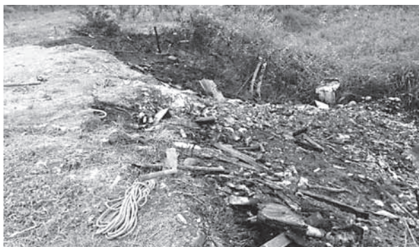
▲ゴミ焼きから火災に至った現場
