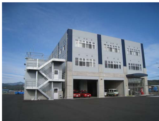
防災拠点（安芸市防災センター）
