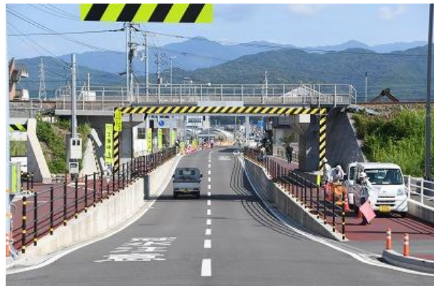
（県道）安芸中インター線供用区間
