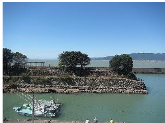
伊尾木漁港石積堤
