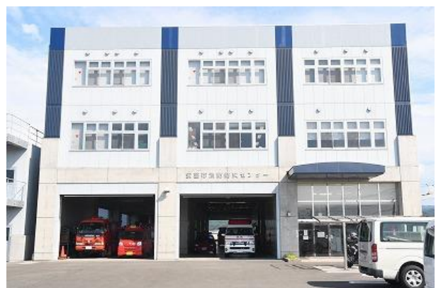
防災拠点（安芸市防災センター）
