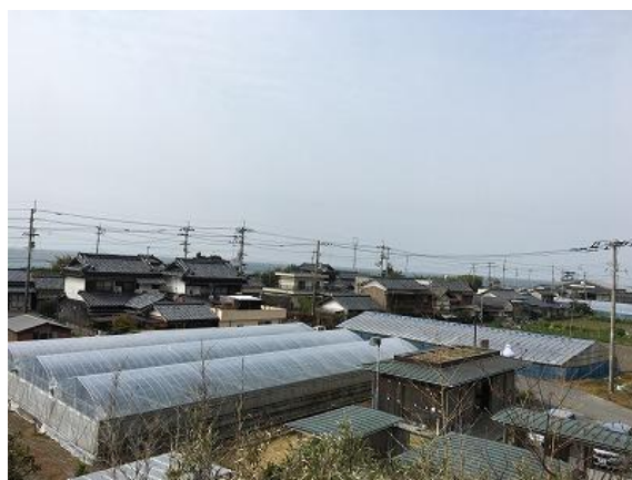
生活拠点（穴内駅・穴内郵便局周辺）
