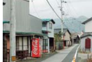
▲変圧器が付いている電柱は倒れる可能性が高く、傾いているものは要注意。切れた電線には絶対に触らない。古いブロック塀は震度5強以上の揺れで倒壊の恐れあり。
