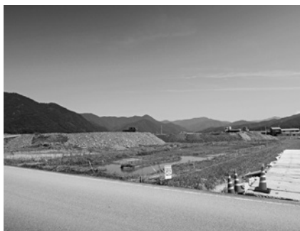
統合中学校建設地
