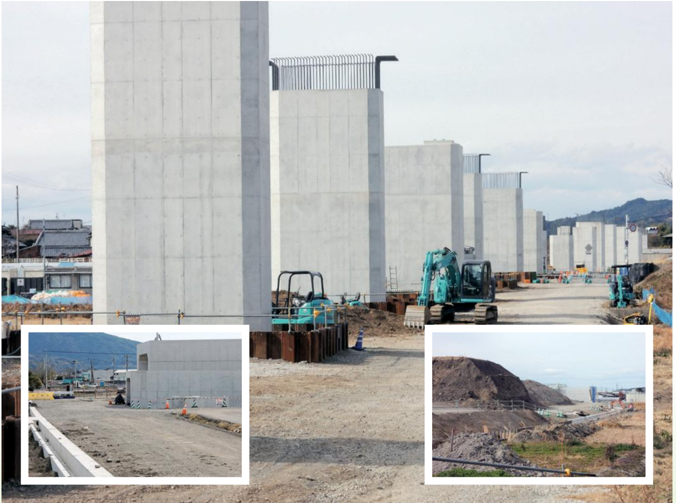
東部自動車道安芸市工区
