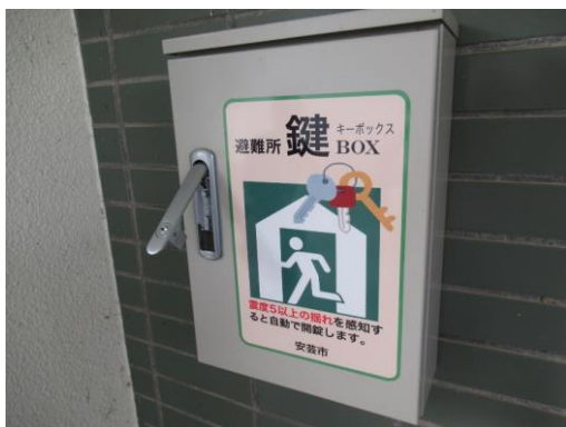
※設置された感震キーボックスのイメージ
