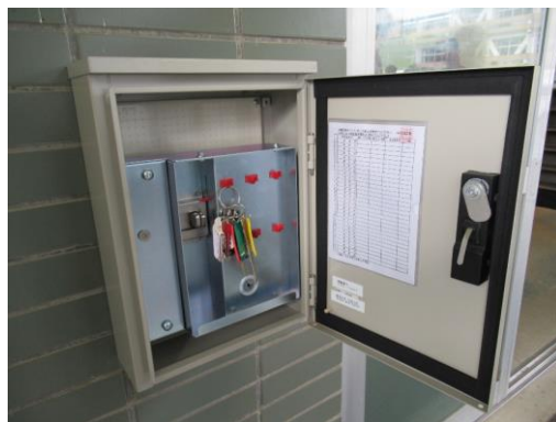
※設置された感震キーボックスのイメージ
