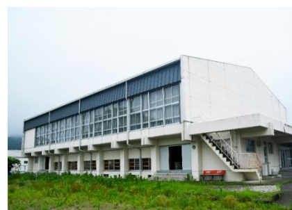
図 2-8 安芸中学校体育館
