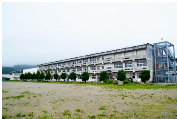
図 2-5 安芸中学校外観(南側)
