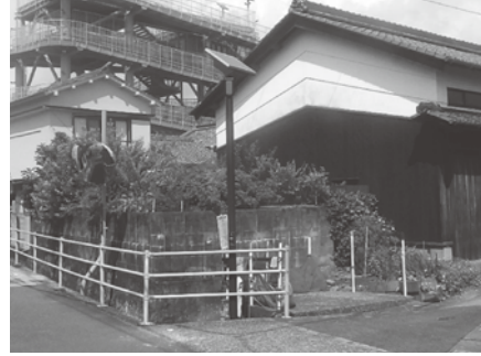
▲津波避難タワー9号（伊尾木中組西）前
