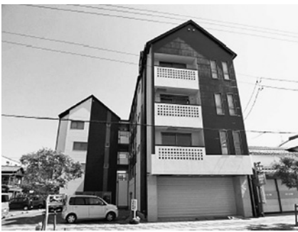
▲コンタクトセンター予定地
