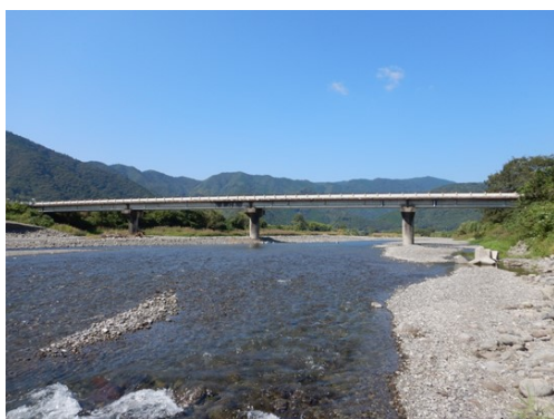
橋長の長い橋の例（沢の平橋）
