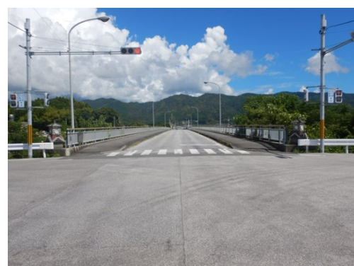
道路種別が市道1級の橋の例（春日橋）
