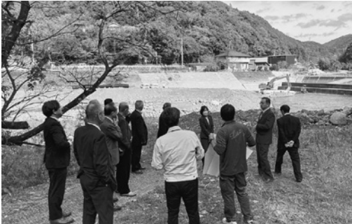
▲有井頭首工災害復旧工事
