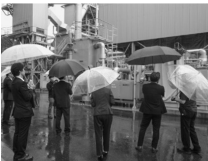
▲木質バイオマス発電施設
