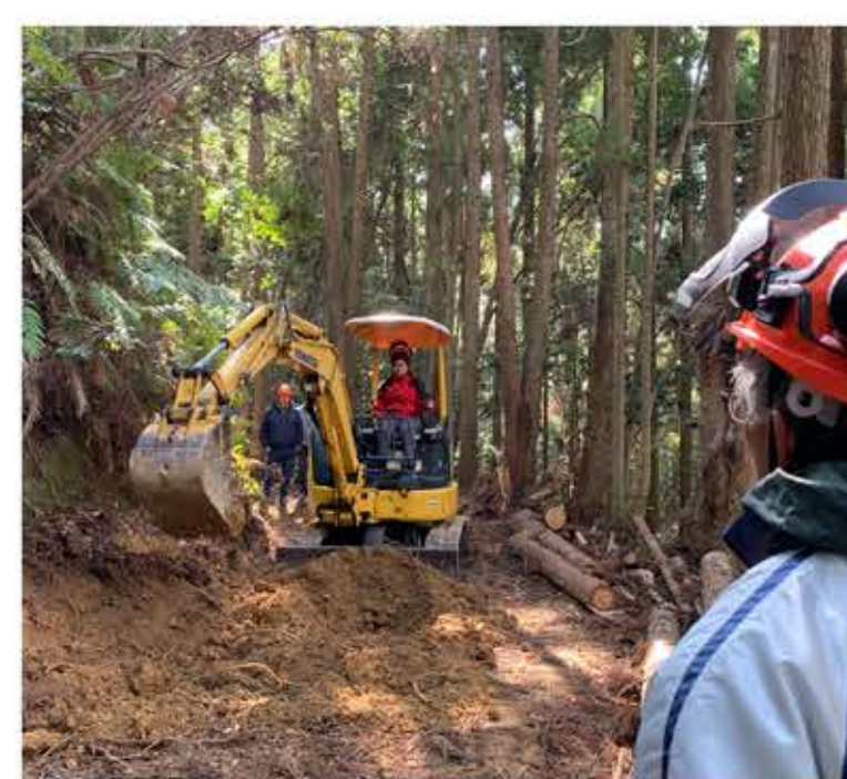
木を運び出すための作業道を作る研修
