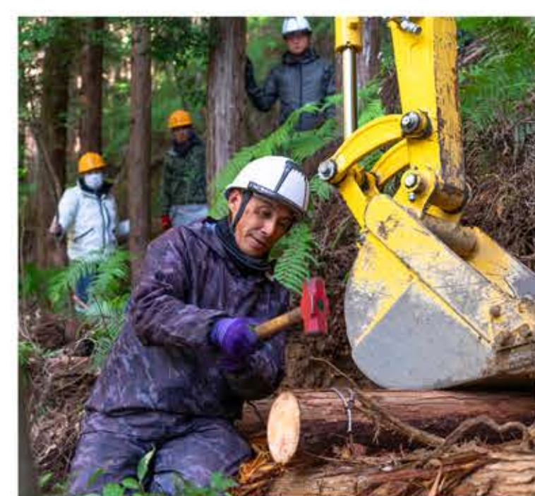
作業で伐った木を再利用した路盤の補強
