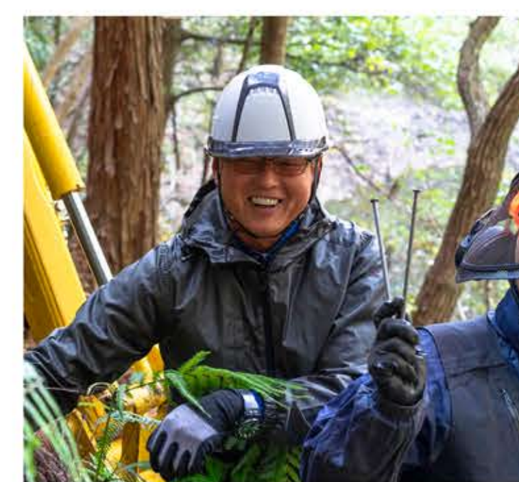
壊れにくい環境負荷の小さな作業道づくり
