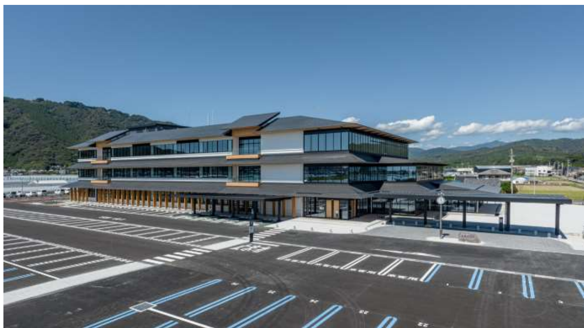
▲安芸市役所新庁舎（南東外観）
