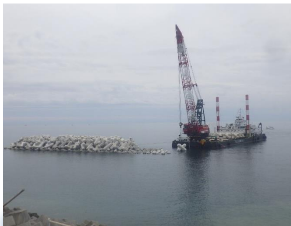
穴内漁港海岸消波ブロック設置
