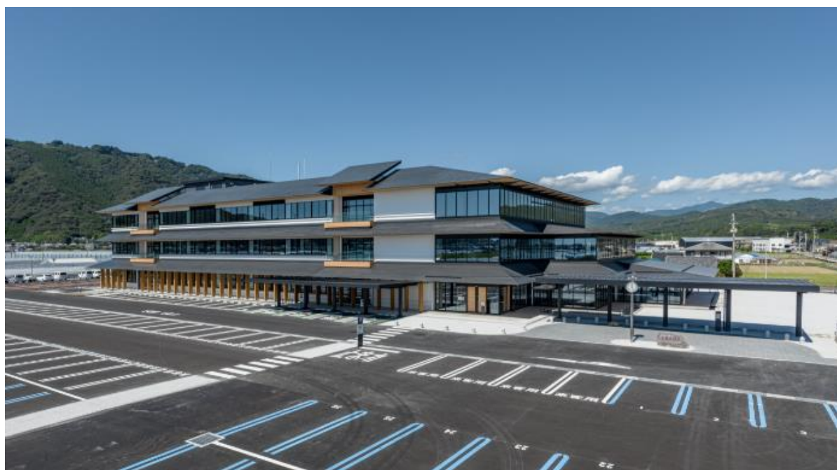
▲安芸市役所新庁舎（南東外観）
