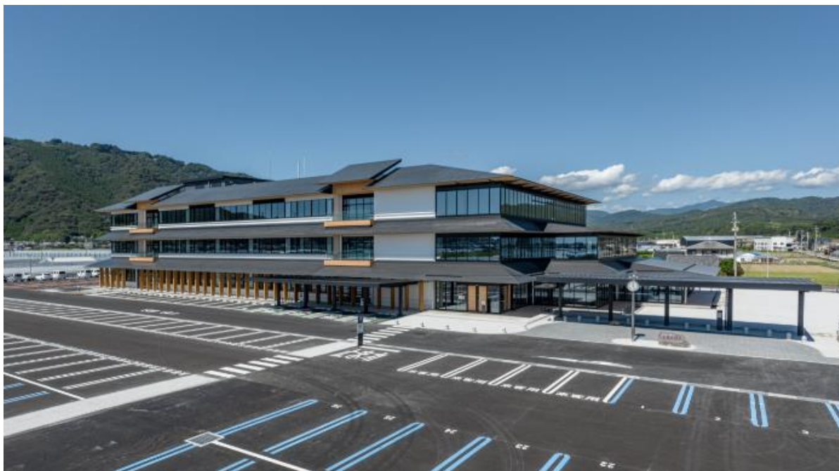
▲安芸市役所新庁舎（南東外観）
