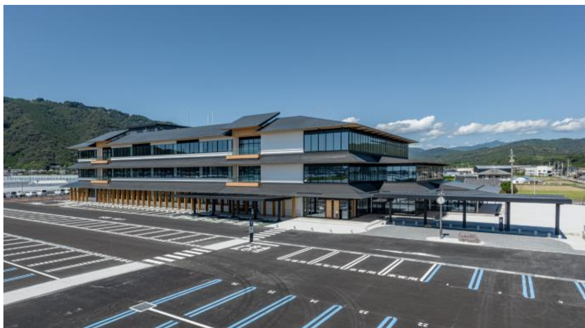
▲安芸市役所新庁舎（南東外観）
