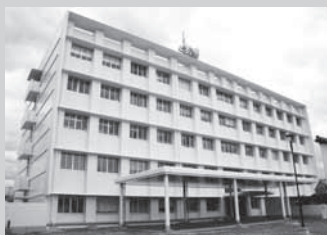
▲県総合庁舎新築
