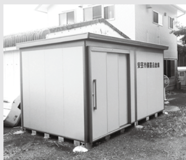
▲赤野地区備蓄倉庫
