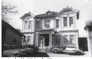
▲安芸郡公会堂
