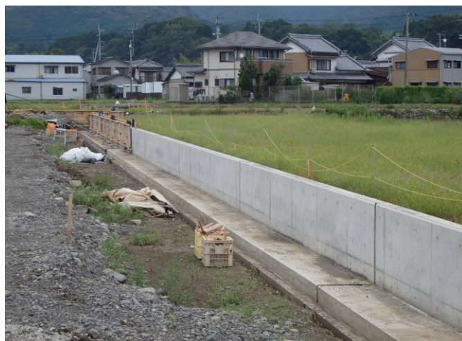
敷地西側の道路擁壁工事
