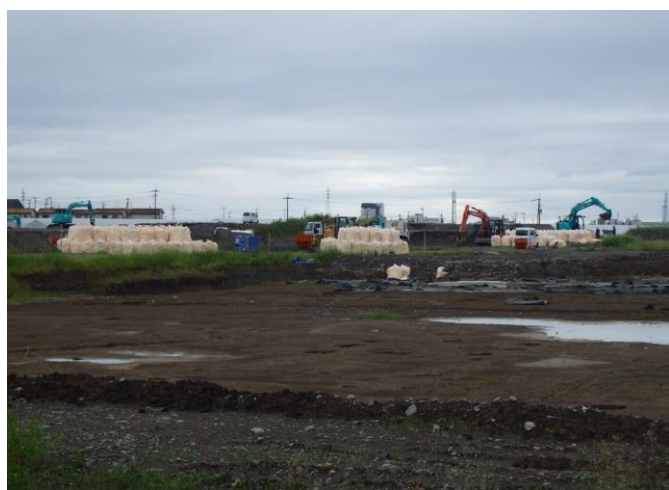
敷地北側から見た工事の様子
