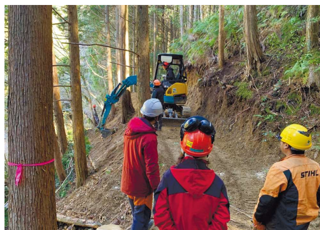
環境負荷の小さな作業道の開設
