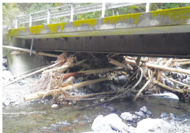
森林から発生した流木は橋梁等の施設の破損の原因にもなる
